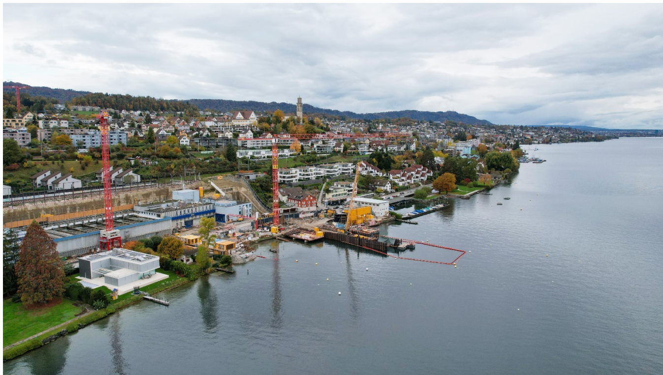
Abbildung 2; Situation Seebad Bürger I im November 2023 aufgrund des Baus des kantonalen Entlastungsstollens.
